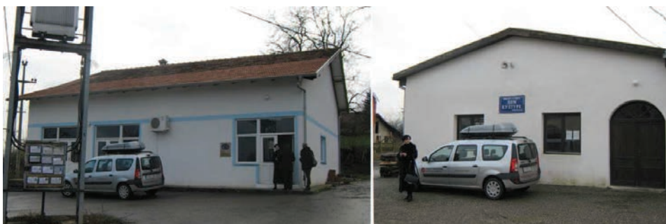
Slika 4: Arhitektura Domova kulture opštine Jagodina sa desne na levo: Kovačevac, Ribnik 6
