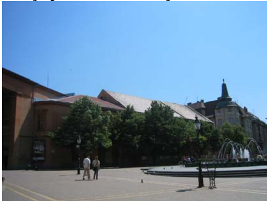
Stanje pre rekonstrukcije
