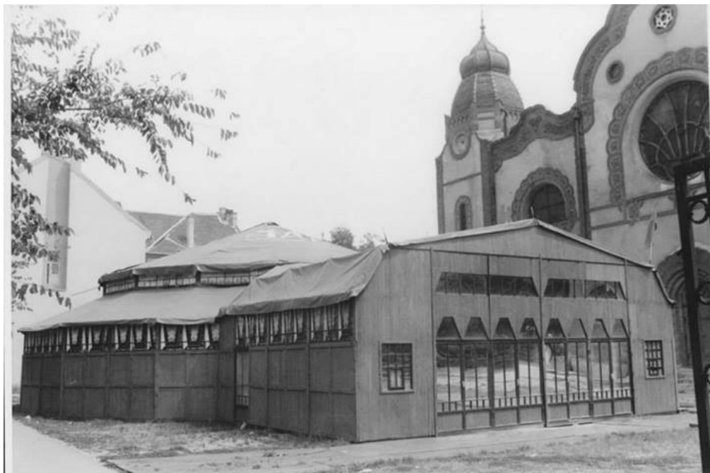
Šator u dvorištu Sinagoge
